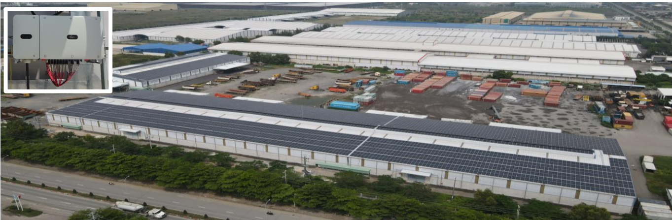
Dự án Điện Mặt Trời áp mái Công Nghiệp tại tỉnh Đồng Nai, Việt Nam Quy mô hệ thống: 1MW
